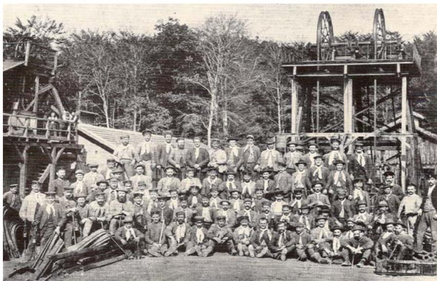
Bergleute der Grubenabteilung Burbach-Stollen vor dem Kirschheckschacht II. Links das Seilscheibengerüst aus Holz des 1889 von der Stollensohle bis zu Tage hochgebrochenen Wetterschachtes.
