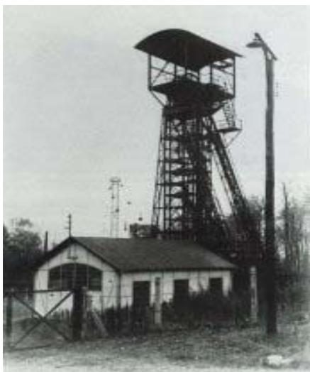
Teufe: Das Schachtiefste lag bei +158,63 m NN in 131 m unter der Hängebank.
